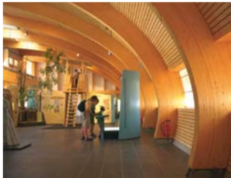
Hochqualitatives BSH mit LEUCO Minizinkenfräser erzeugt
